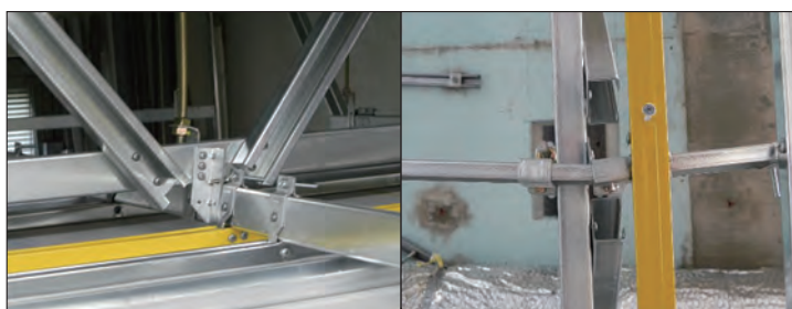
アシストバー有 (写真黄色の野縁がアシストバー)
