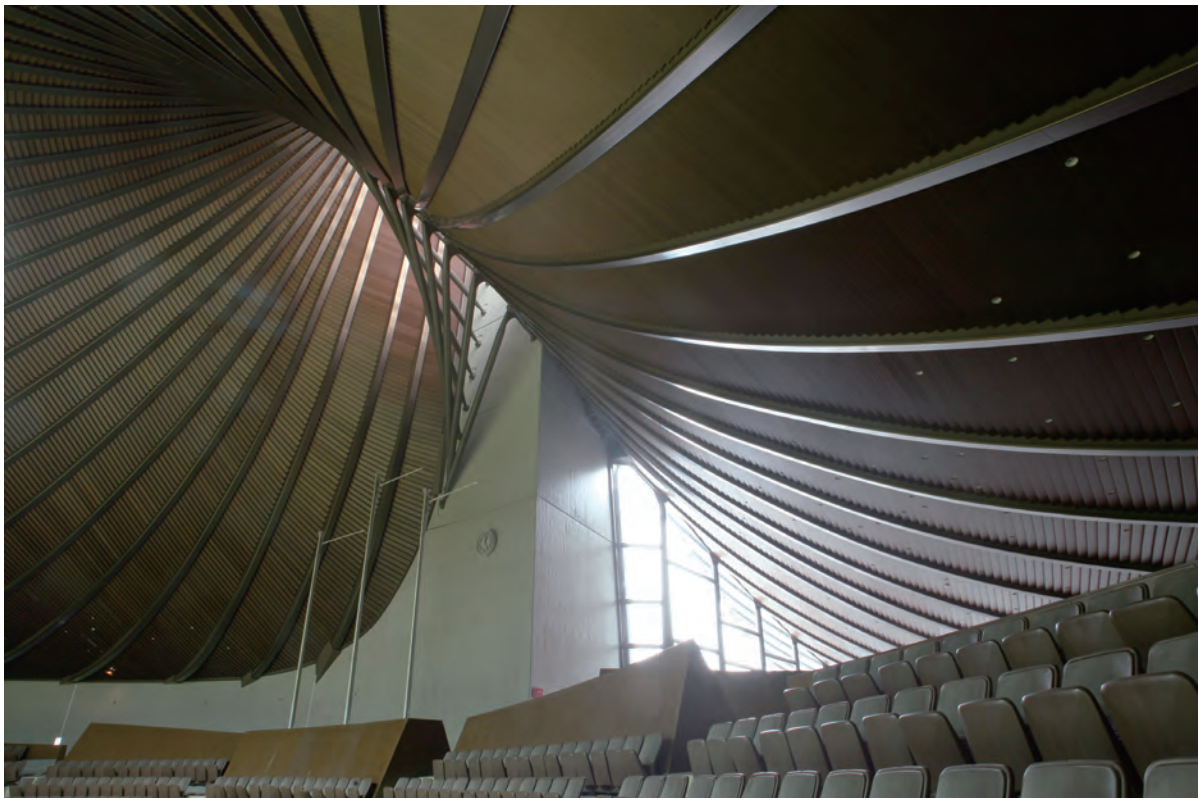
7 国立代々木競技場（第二） [設 計] 丹下都市建築設計・久米設計共同体 東京都／2020 [施 工] 大林組 <アリーナ>アルミ突板ルーバー天井 耐震補強天井
