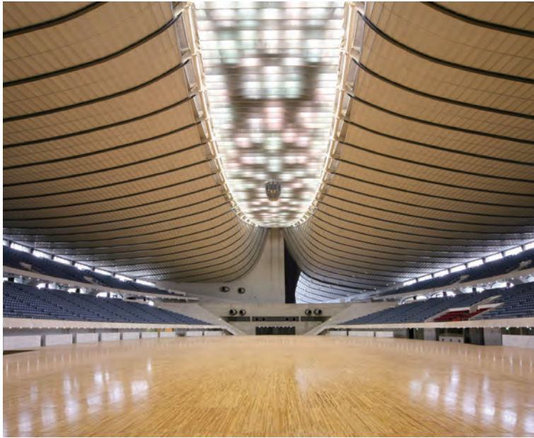
6 国立代々木競技場（第一） [設 計] 丹下都市建築設計・久米設計共同体 東京都／2019 [施 工] 清水建設 <アリーナ>アルミエキスパンドメタル天井（アルマイト仕上） 耐震補強天井
