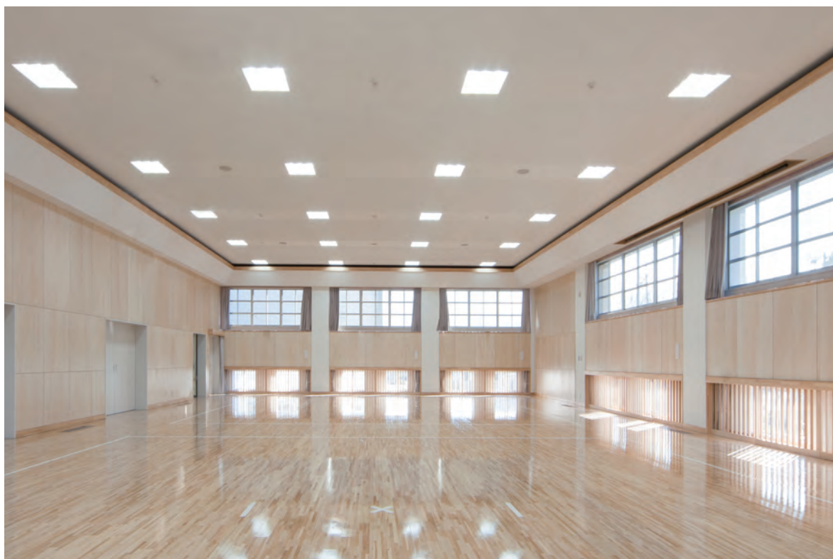
19 日進市立竹の山小学校・日進北中学校 〔設計〕 安井建築設計事務所 愛知県／2013 〔施工〕 鴻池組 JV ＜武道場＞落下低減天井
