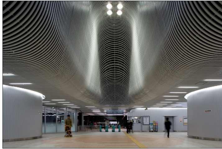
埼玉新都市交通ニューシャトル「鉄道博物館駅」 W50×H25 @100 (K型)
