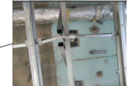
アシストバー無 (野縁受が、くの字に変形)
